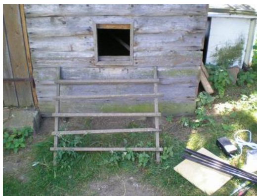
Obr. 2. Vstupní otvor do kurníku před montáží.
